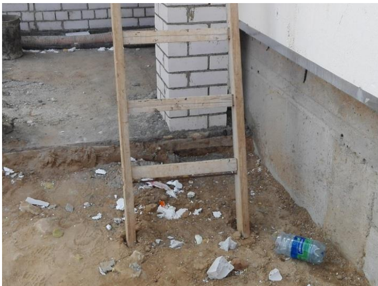
Отсутствие на приставной лестнице устройств, предотвращающих возможность сдвига и опрокидывания
